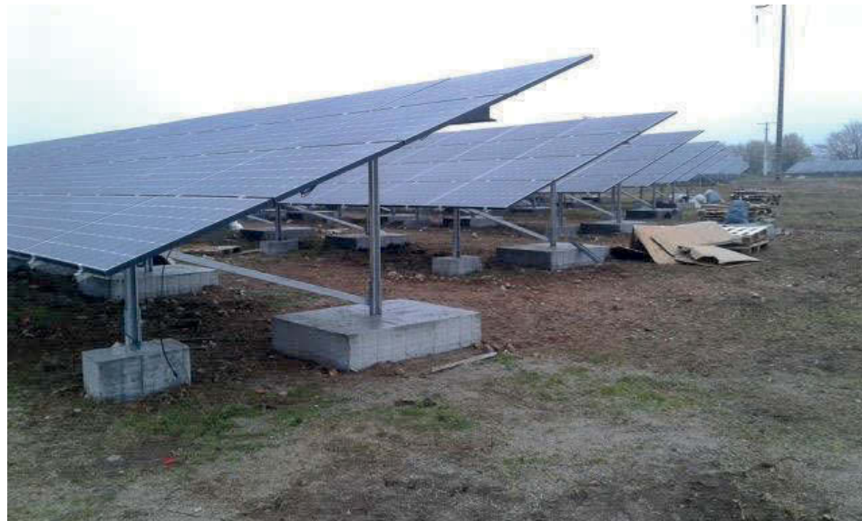
Figure 8 : Les panneaux posés sur longrines béton (Source : ADIWATT)
