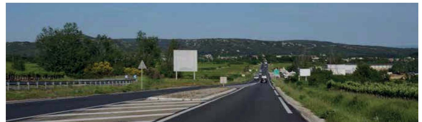
RD6100, un axe important sur le territoire, bénéficiant de vues ouvertes sur le paysage environnant
