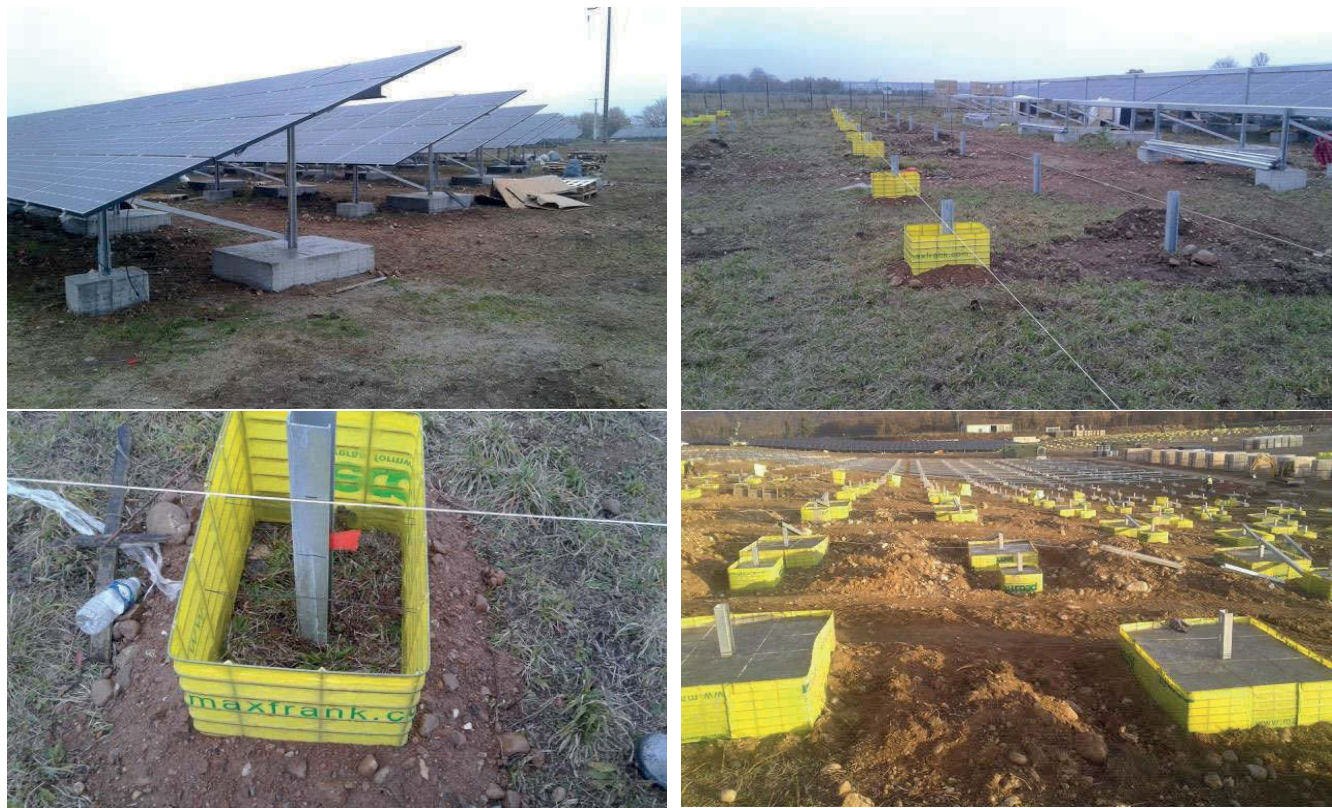
Figure 40 : descriptif de la mise en place des longrines en béton
