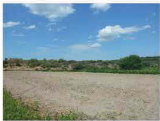
3 - Vue sur la zone de talus depuis la RD192
