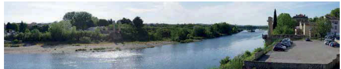
Vestiges du pont suspendu sur la Gard (5) à Remoulins
