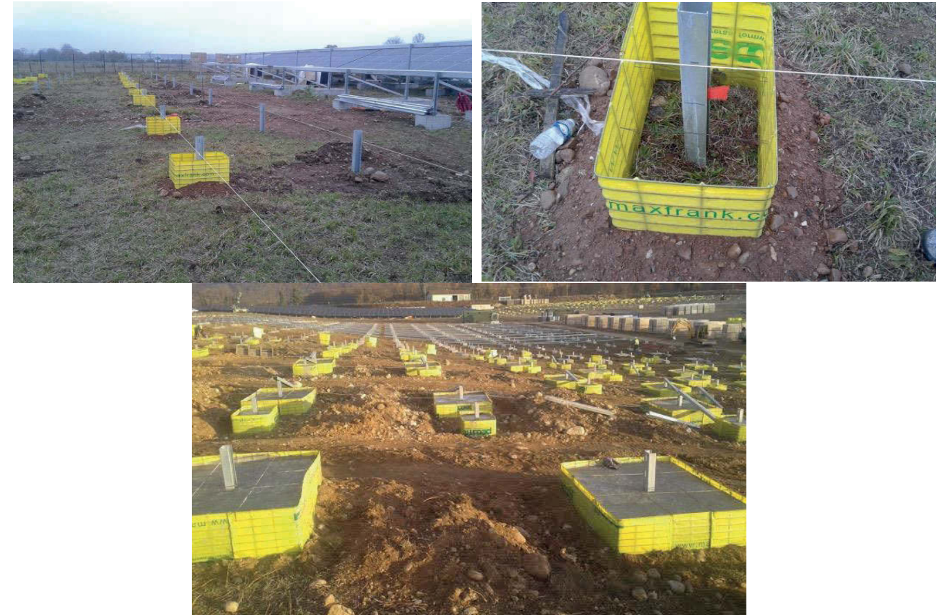
Figure 7 : Installation des longrines béton (Source : ADIWATT)
